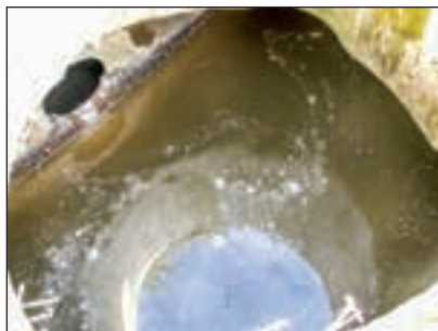
Obr. 4. Pohled do odtokové komory dobře fungujícího septiku (foto archiv VÚV TGM, v.v.i.)
