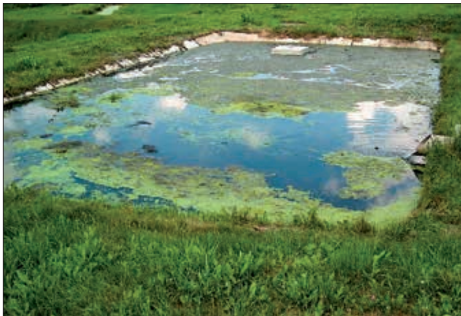
Obr. 9. Zemní těsněná usazovací nádrž zarostlá vláknitými řasami (foto archiv VÚV TGM, v.v.i.)
