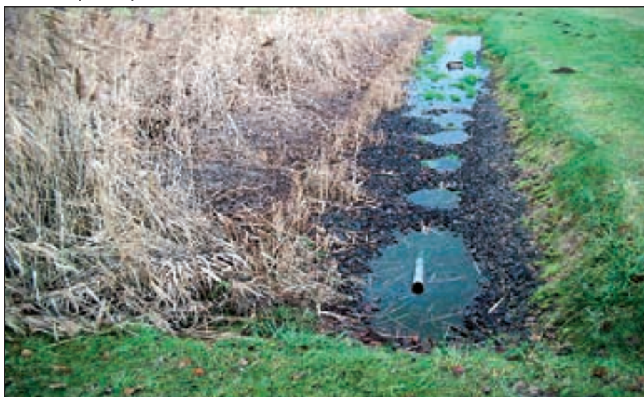
Obr. 32. Rozsah kolmatace kořenového filtru Olší nad Oslavou po deseti letech provozu (foto archiv VÚV TGM, v.v.i.)
