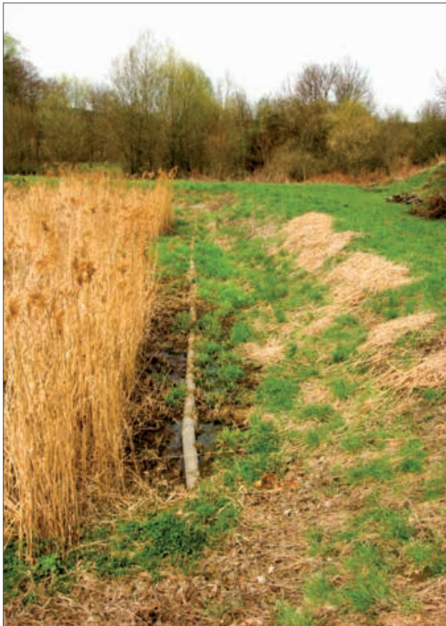
Obr. 30. Kolmatace nátokové zóny kořenové čistírny Hostětín v roce 2012 (foto archiv VÚV TGM, v.v.i.)
