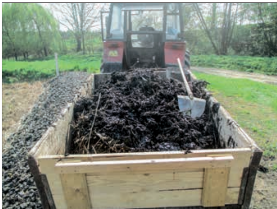
Obr. 48. Materiál sebraný z povrchu části zakolmatované přítokové zóny kořenové čistírny Bezděkov pod Třemšínem (foto archiv VÚV TGM, v.v.i.)
