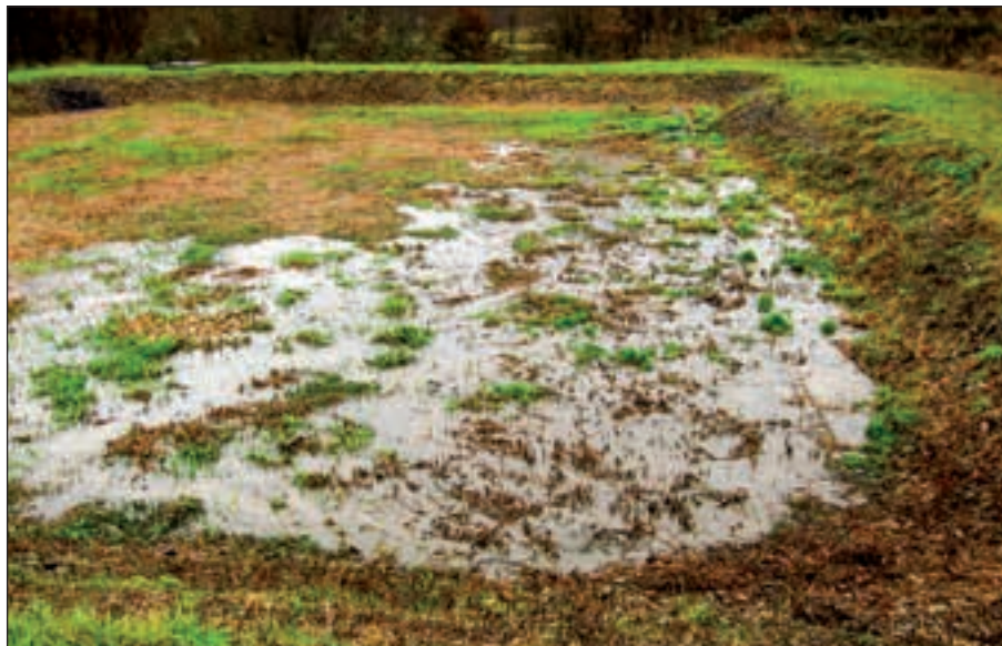
Obr. 29. Kolmatace nátokové zóny kořenové čistírny Hostětín po 13 letech provozu (foto archiv VÚV TGM, v.v.i.)
