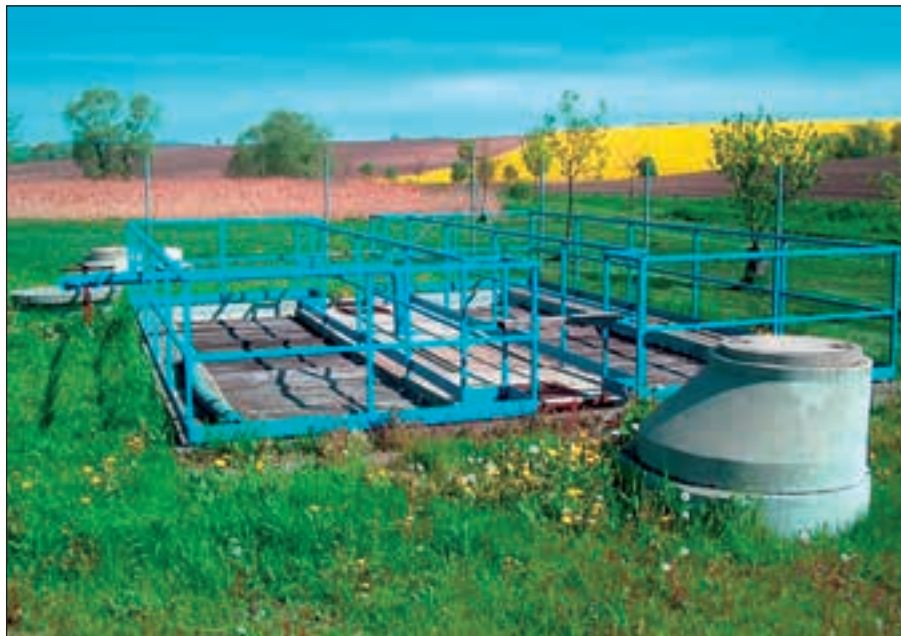
Obr. 7. Šterbinová usazovací nádrž realizovaná na kořenové čistírně (foto archiv VÚV TGM, v.v.i.)
