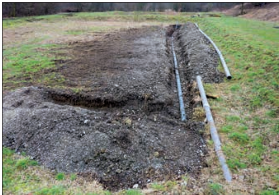
Obr. 31. Pohled na odkrytou nátokovou zónu prvního filtru kořenové čistírny Hostětín před výměnou filtračního materiálu (foto archiv VÚV TGM, v.v.i.)
