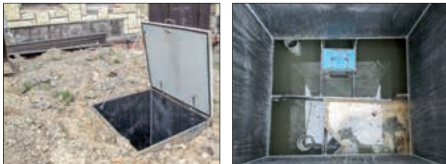
Obr. 5. Příklad sledovaného biologického vícekomorového septiku vyvinutého v rámci projektu TA02021032; vlevo umístění na pozemku, vpravo pohled do jednotlivých sekcí během provozu (foto archiv VÚV TGM, v.v.i.)
