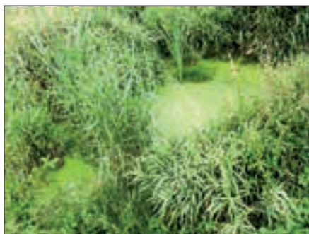
Obr. 24. Ukázky zaplavení povrchu náplně filtračních polí v důsledku kolmatace (foto archiv VUV TGM, v.v.i.)
