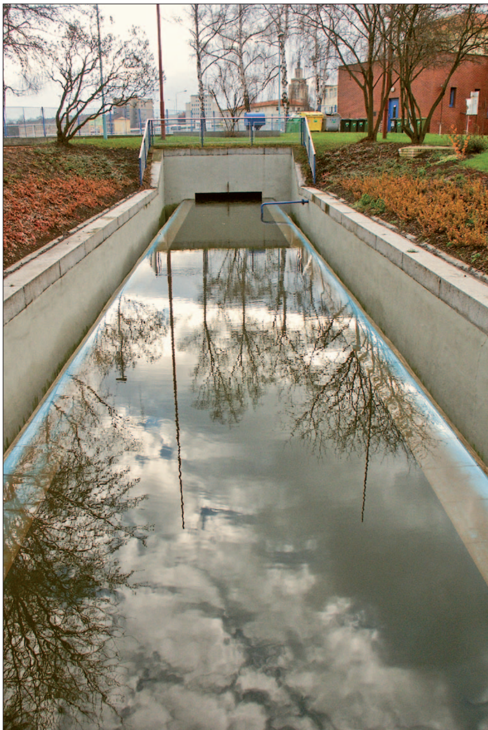
Vtoková část žlabu s přelivem
