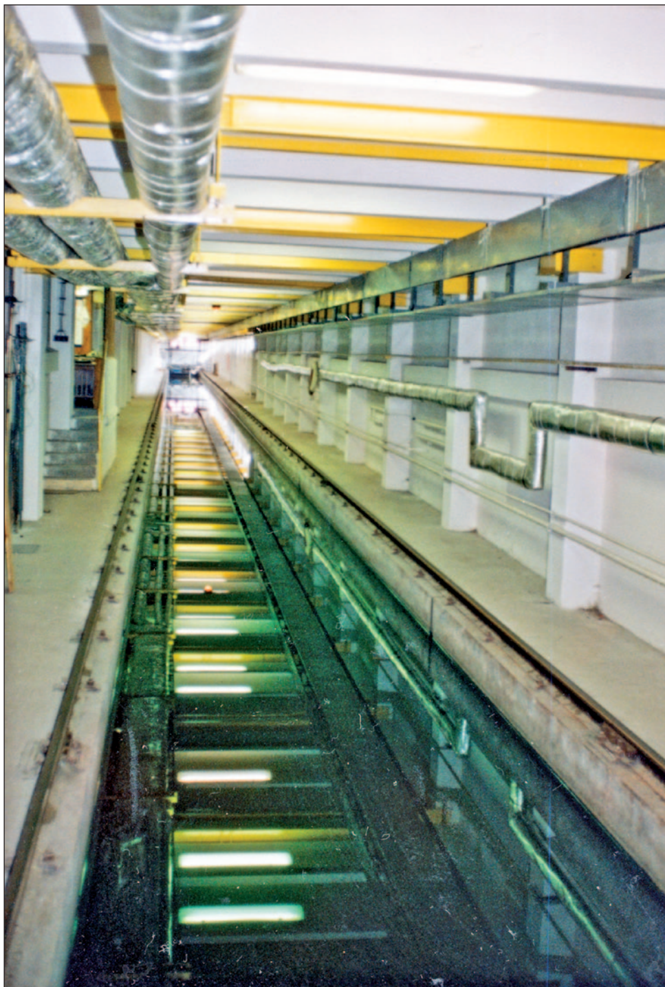
Vnitřní prostor kalibračního žlabu (stav 20. 4. 1994)
