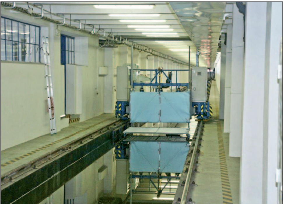
Vozík s instalovanou plošinou
