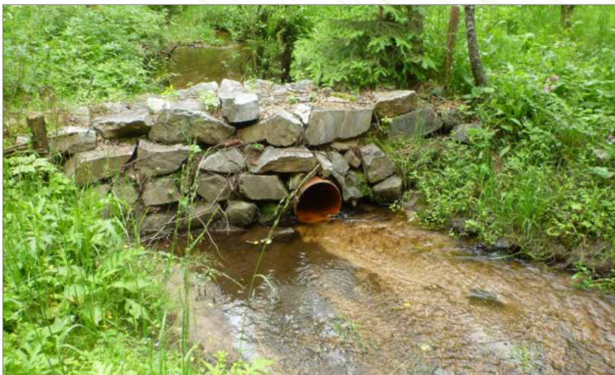
Obr. 144. Polopropustná přehrážka. Tato přehrážka je za normálního vodního stavu průtočná, v případě zvýšení průtoku ale protéká jen část určená kapacitou trubky. Nadbytečný průtok se vzedme a vyběžší určeným směrem. Trubka musí být stále zavodněna a bez proudového skoku, aby netvořila migrační překážku pro pstruhy.
