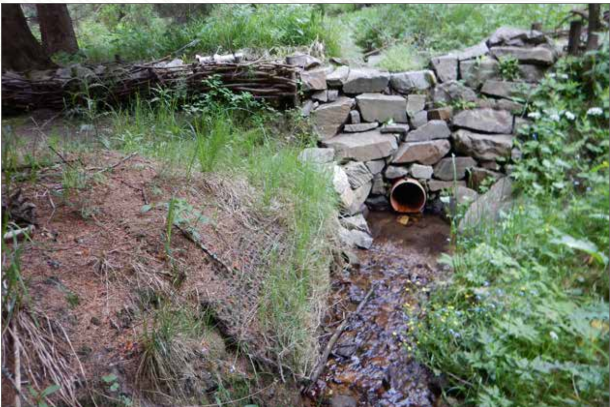
Obr. 147d. Podobné místo jako na Obr. 147a po průchodu několika povodní (po kterých následovalo vyčištění okolí trubky) a zapojení vegetace.
