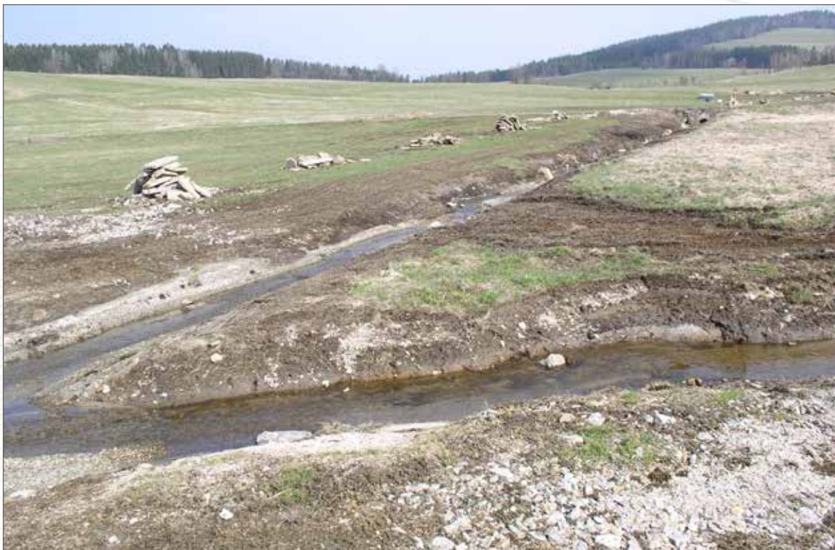
Obr. 134a. Zbytinský potok a Sviňovická strouha (ústí – vpravo) bezprostředně po revitalizaci. Vedle koryta Zbytinského potoka jsou patrné zbytky vytrhaného betonového opevnění, tok zůstal zahlouben a napřímen.
