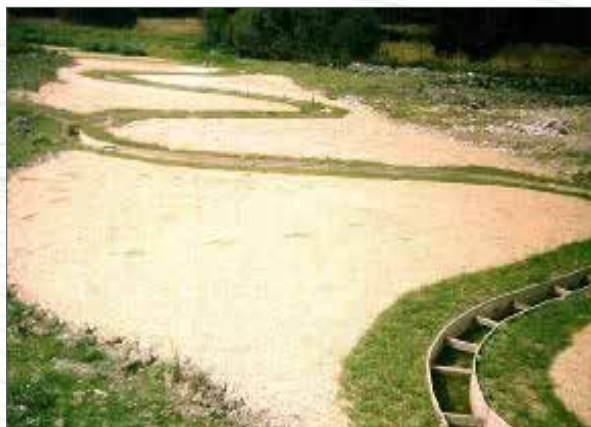
Obr. 138b. LORP – NPP Lužní potok – kolem dosud suchého koryta je vidět postupně prokořeňující drn. Zbylá plocha obou ORP pak bude překryta překompostovanou zeminou obohacenou o vápník v organické podobě (blíže k možným chybám při konstrukci viz Příloha 4).
