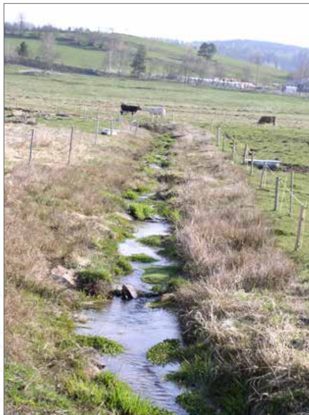
Obr. 7. Správné začlenění toku revitalizované Sviňovické strouhy do pastevního areálu s plným vyplocením koryta a okolního pásma.
