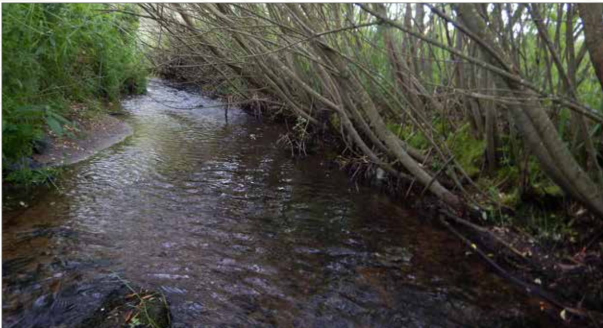
Obr. 200a. Celkový pohled od hladiny Zbytinského potoka na nejdelší oživený haťošterkový válec po deseti letech (v roce 2016).
