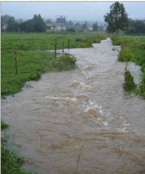
Obr. 151b. Eroze širokého a nepřírodně kapacitního koryta vlivem bouřkových průtoků v srpnu 2005.
