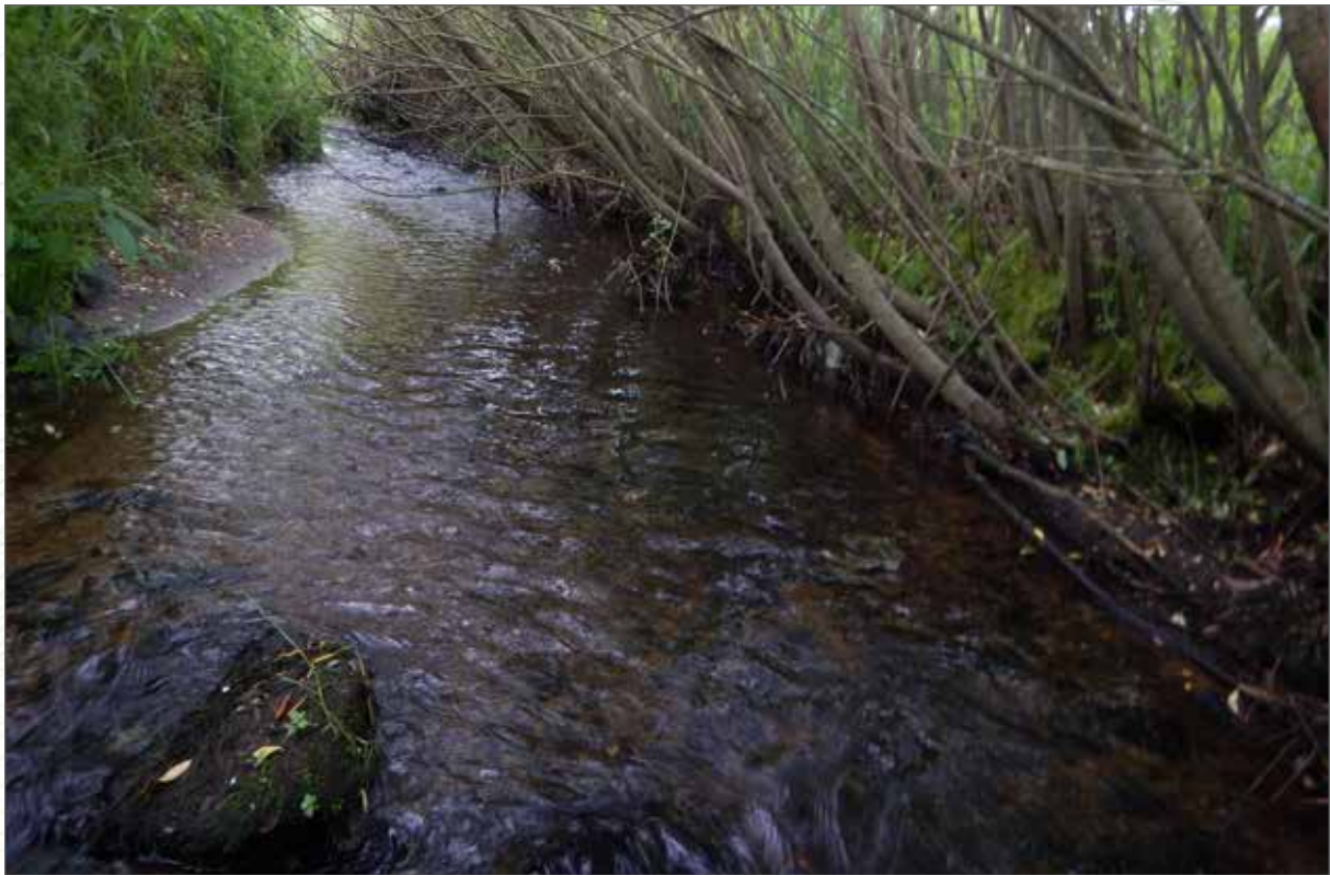
Obr. 152a. Příklad haťošterkových válců nevyžadujících údržbu. Stav oživených haťošterkových válců 10 let po založení (800 m n. m.), čistý průtočný profil, mladé kmínky se drží vzpřímeně.
