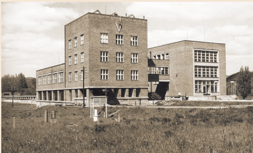
Pohled na budovy A, B areálu v Praze-Podbabě
