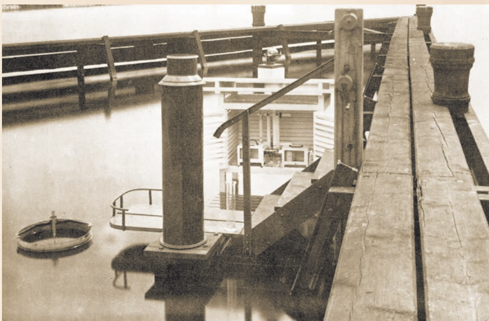
Plovoucí výparoměrná stanice na plavebním kanále u ústavu
