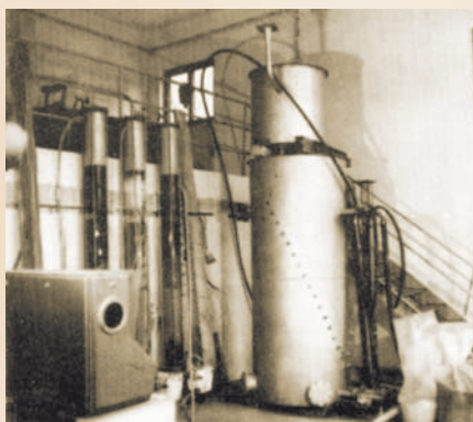
Modelové sestavy pro studium technologie úpravy vody – lokalita Vír
