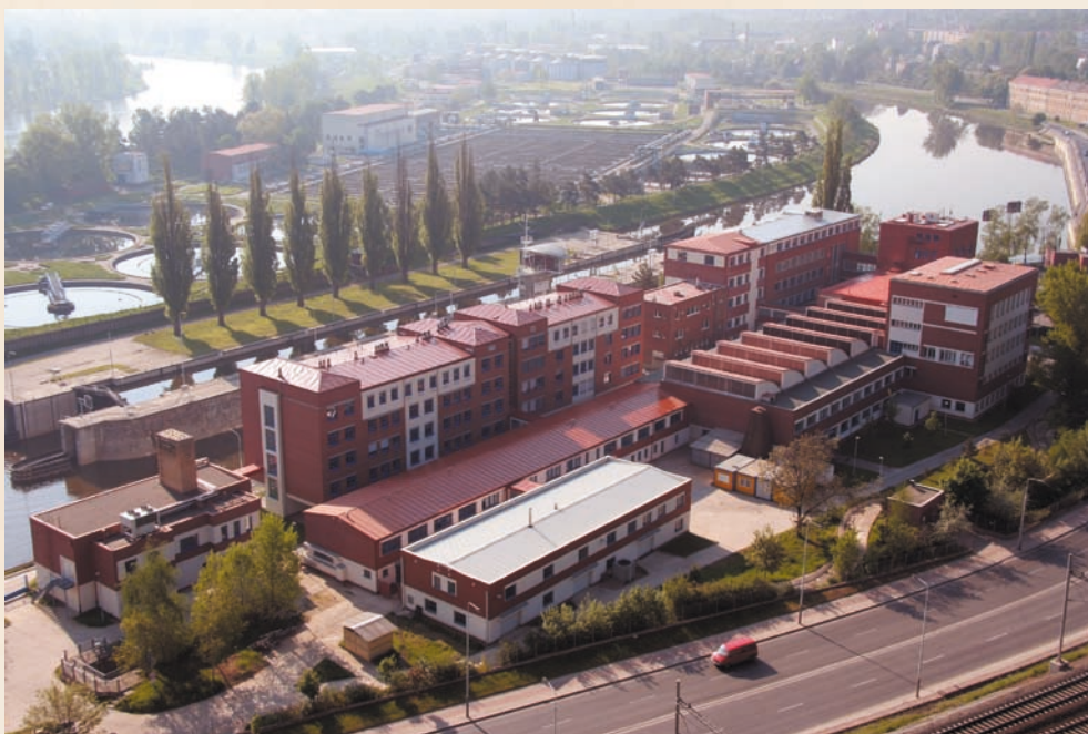
Současný pohled na areál VÚV T. G. Masaryka v Praze-Podbabě
