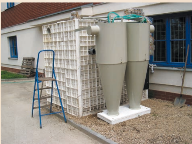
Zkušební laboratoř vodohospodářských zařízení
