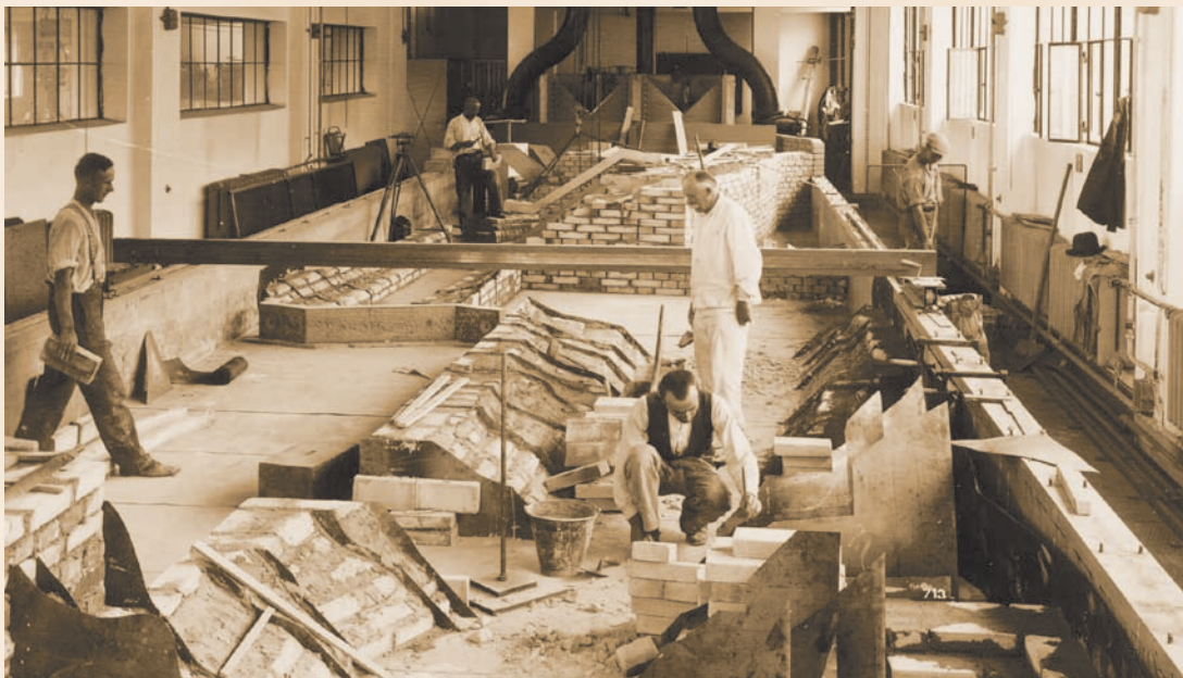
Ilhned po dokončení budovy A začala v hydrotechnické laboratoři stavba modelu vodního díla Štěchovice
