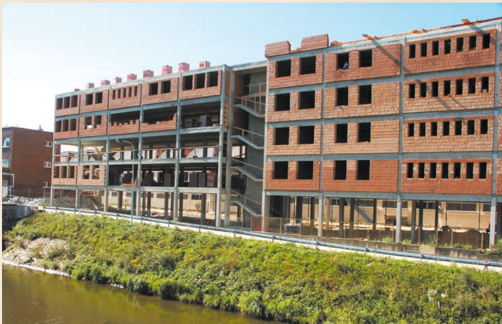
Výstavba nové části ústavu po povodni
