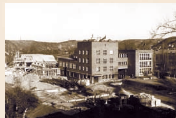
Stavba budovy C (1949)
