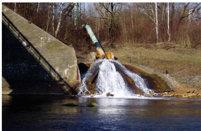
Obr. 21. Specifikem moravskoslezské části povodí Odry v oblasti problematiky bodových zdrojů znečištění je vypouštění důlních vod do vod povrchových – snímek zachycuje vyústění čerpaných důlních vod z vodní jámy dolu Jeremenko do řeky Ostravice Fig. 21. A specific issue for the Moravian-Silesian part of the Odra River basin in regard of spot pollution sources is the release of mine waters into surface water bodies – the image shows the outflow of mine water pumped from a water pit of the Jeremenko Mine into the Ostravice River
